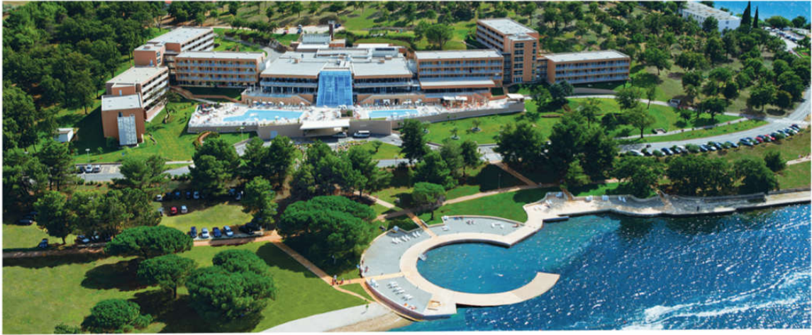
Hotel Molindrio nakon rekonstrukcije
